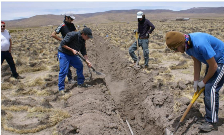
Il a fallu creuser 5 km pour poser une conduite PVC. Le tout à 3 600 m d'altitude, où l'air se fait plus rare. DOC REMIS
